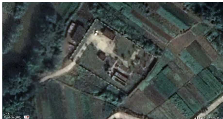
石钟镇污水处理厂
