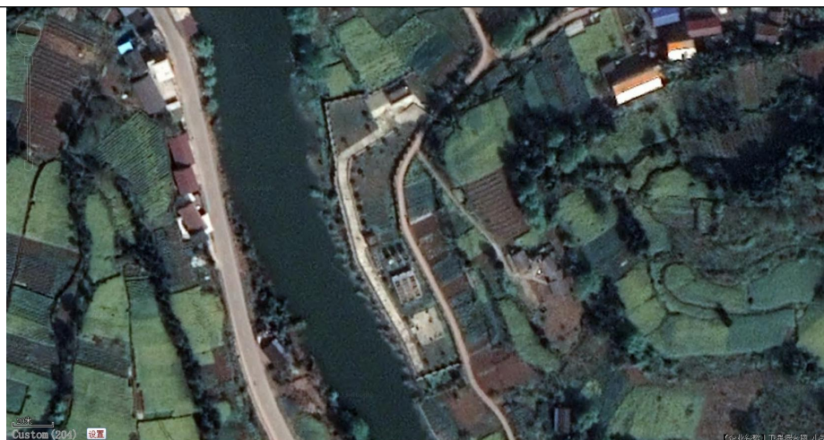
涌泉镇污水处理厂
